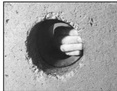
14. Tætningen trækkes ud til kantz af rørvæg. OBS! Det er vigtigt, at der er lidt glidemiddel påført i hullet for at udligne friktionen.
