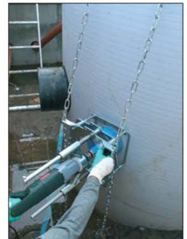
Anbringning på Ø 2500 mm pumpebrønd.
