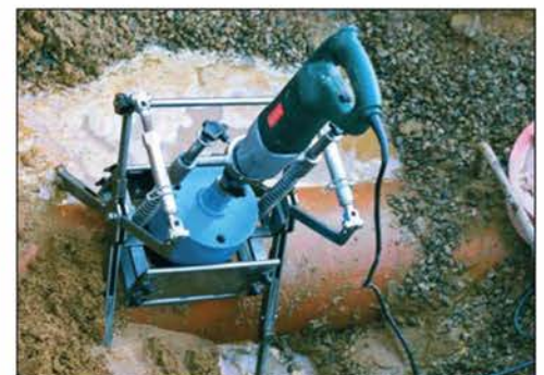
Anbringning på PVC Ø 300 mm SN 8.
