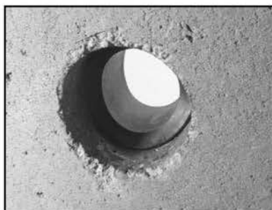
15. Tætnings rette placering set indvendigt fra i røret. OBS! De små flige på tætningen skal ligge bagudrettet.
