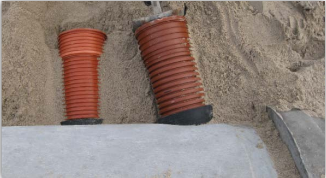
Tilslutning vinkelret på og med svagt medløb.
