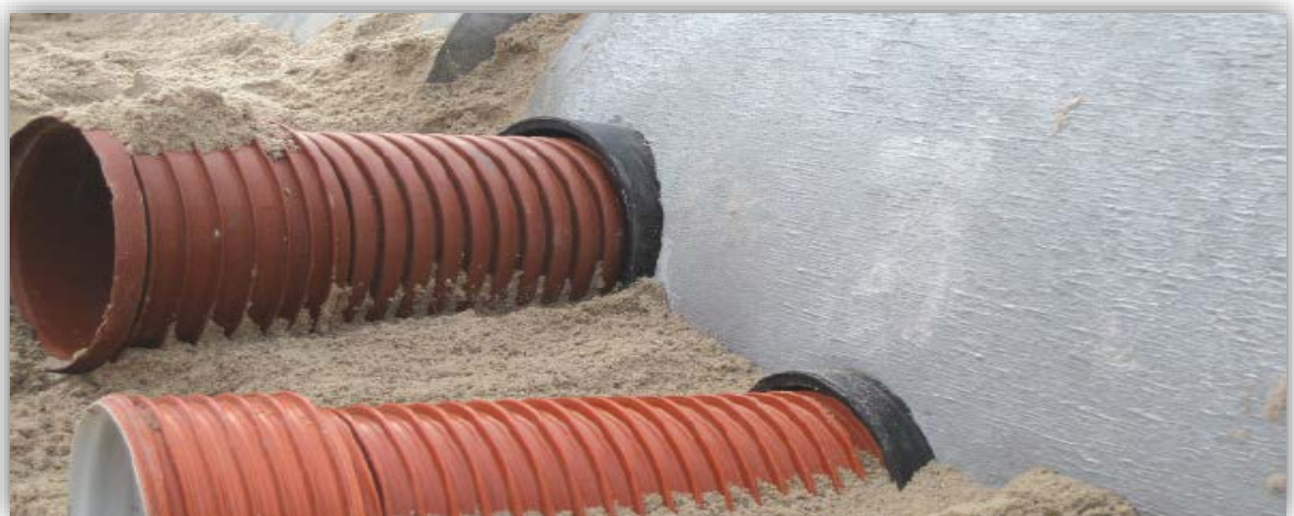
Påboring med hhv. ribberør og korrugeret rør.
